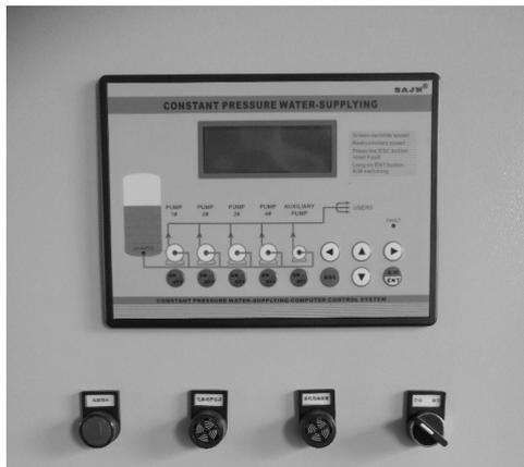
ON/OFF: 启动 / 停止所对应水泵（手动运行时使用，自动运行无效。当泵停止时按下此键启动该泵工频运行，当泵运行时按下此键停止该泵工频运行）。
